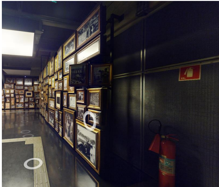
Figura 11 - Detalhe do revestimento acústico formado por placas metálicas e lã de rocha interno
