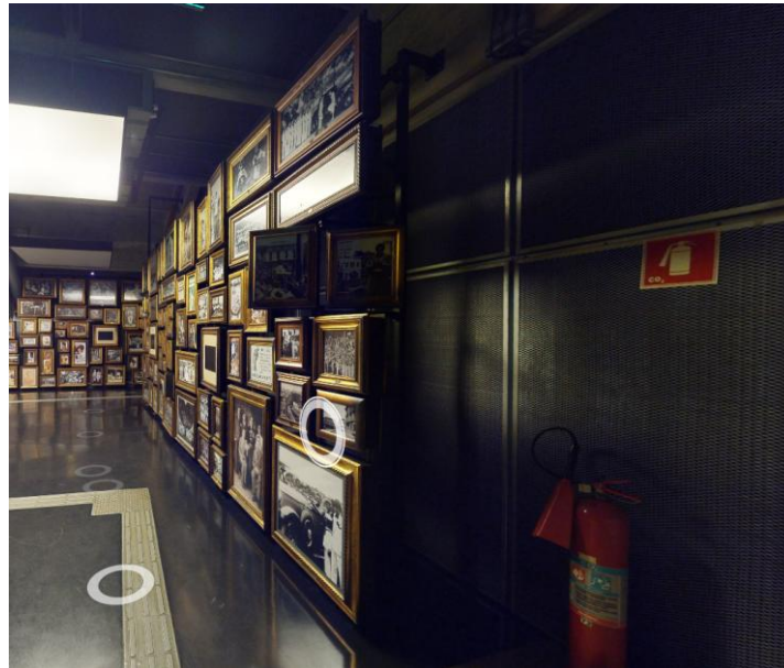
Figura 11 - Detalhe do revestimento acústico formado por placas metálicas e lã de rocha interna
